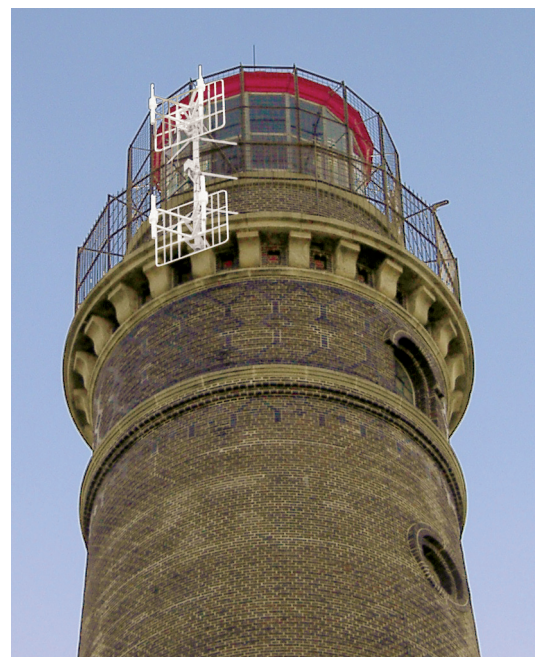
AIS-Antenne am großen Leuchtturm Borkum
